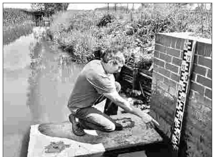
Wasserstandskontrolle am Schöpfwerk Seelow III: Schöpfwerksmeister Thomas Müller liest den Pegel ab. Von hier wird das Wasser über die Vorflut ins Bruch gepumpt. Foto: Michael Märker
